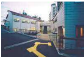
施設全景。軽量鉄骨造2階建ての学童寮棟は2007年に完成し、50名が入所している。ほかに食堂棟と旧幼児寮棟がある。
